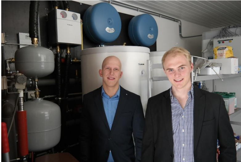
Figuur 9: Brent Bielen en Kris Menten (studenten EMA) installeren een zonneboiler
