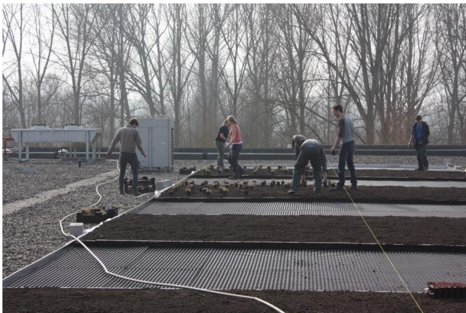
Figuur 16: Aanleg groendak door studenten groenmanagement op het gebouw van PXL-Tech
